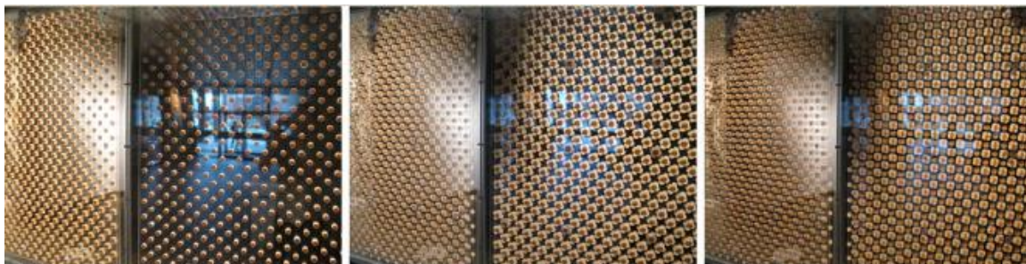
Сл.1.64. Приказ различитих фаза "фритовања" површине структуре и њене провидности (Фотографије прилога сл 1.59. преузете са http://www.adaptivebuildings.com/adaptive-fritting.html , у књизи (фуснота 108 ), А. Фотиадоу прилог на страни 29.)
