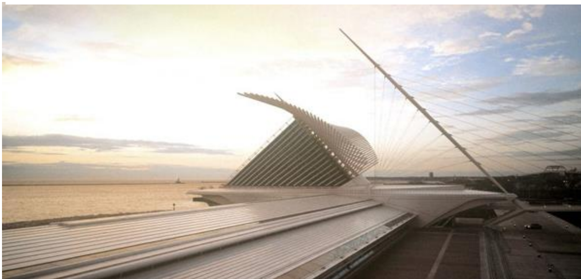
Сл.1.125. фотографија објекта Milwaukee Art Музеја са подигнутим брисолеима (прилог преузет из издања А. Тзонис, "Santiago Calatrava, Complete Works" Rizzoli, 2007)
